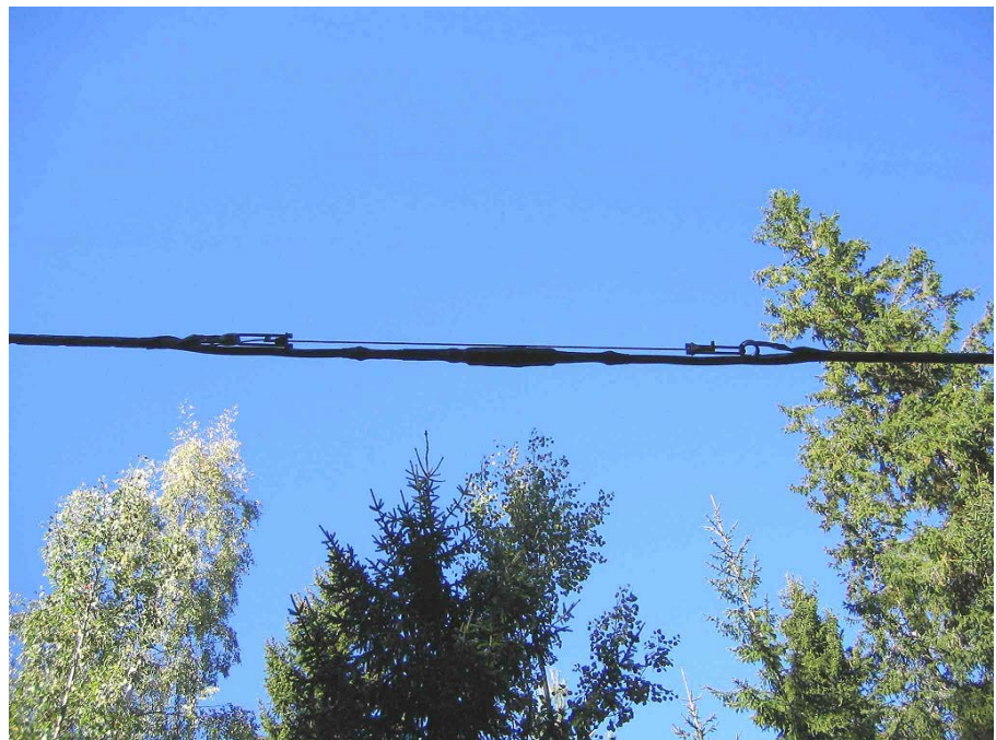
AXCES™ mit zugentlasteter Verbindungsmuffe im Abspann
